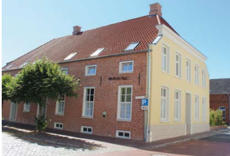
Het nieuwe woontrainingsgebouw in Weener, Norderstraat
