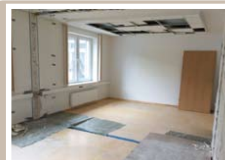
Teils mussten die Büros stark zurückgebaut werden, wenn zwei Räume zu einem neuen Konferenzraum zusammenwachsen sollten.
