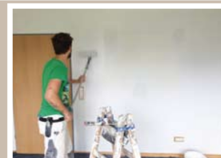
Im September schlug die Stunde der Maler und Bodenverleger, die auch auf den Fluren einiges zu tun hatten.
