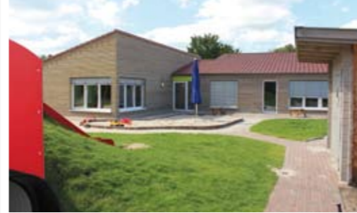
Der Anbau (li.) wurde im August fertiggestellt
